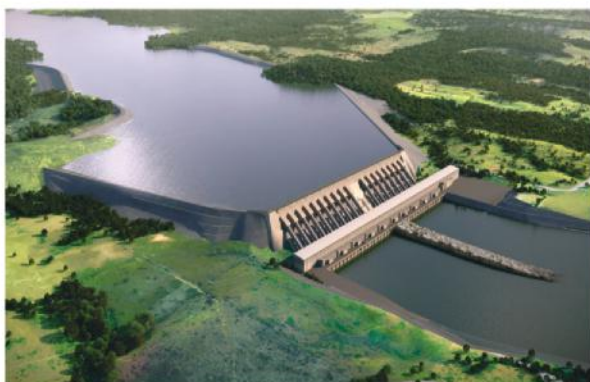
Fornecimento: USINA BELO MONTE/UHE PIMENTAL 1000/810/3500 KVA - 15/12kV - IP 21 810/1000/3500 KVA - Sistema de excitação dos geradores
